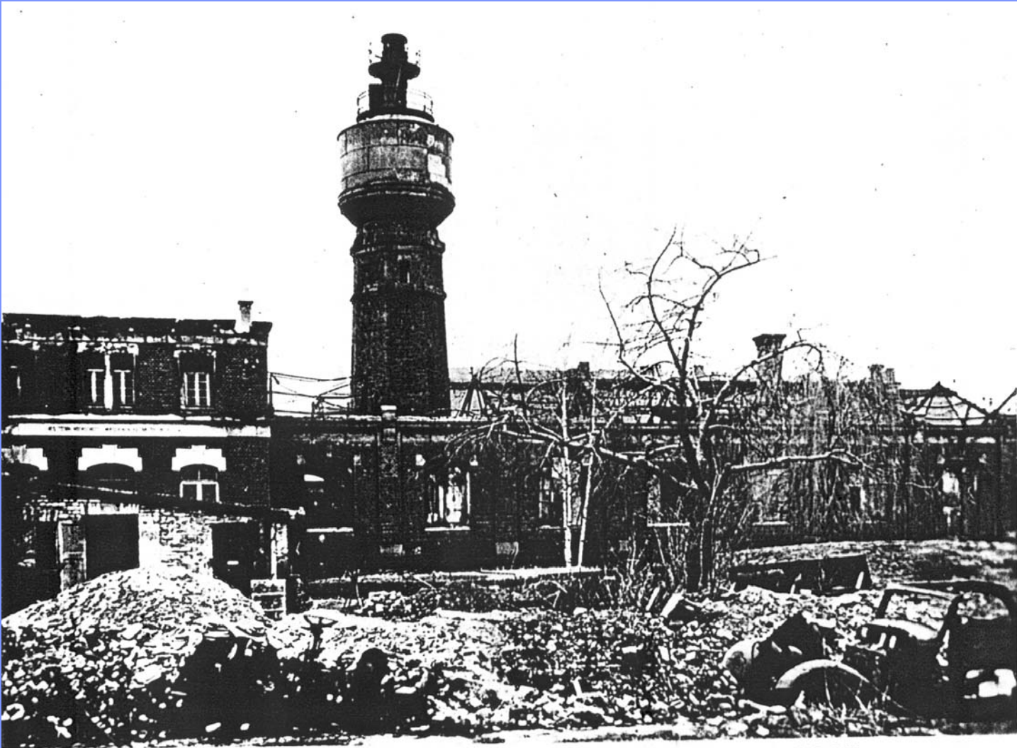
Maschinenlaboratorium nach der Zerstörung 1945
